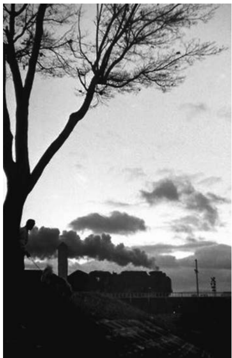
関西本線 佐保川橋梁 1969年
